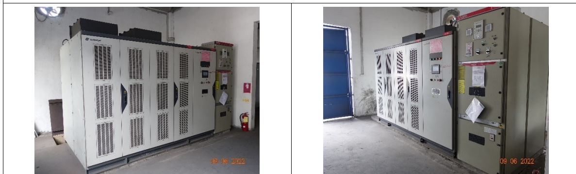
(6) ระบบไฟฟ้าสำรองสำหรับเครื่องดักฝุ่นแบบถาวรของเตาหลอมเหล็ก
